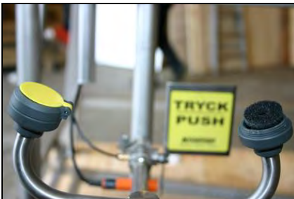
Kuva 10: Silmäsuihkun suuttimet, oikea avattuna
