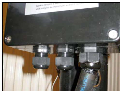
Kuva 7: Kaapelliitännät – Liitäntäkotelo
